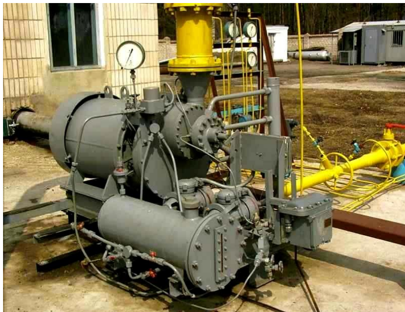
Рисунок 1.6 - Агрегат ТДА-СРТ-100/130-5,5/0,6ВРД на "ГРС-1 Сумы"
