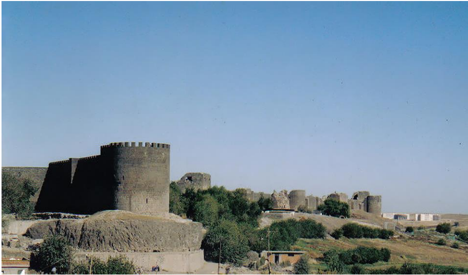
Мури Аміді, зведені Констанцієм II незадовго до облоги міста в 359
