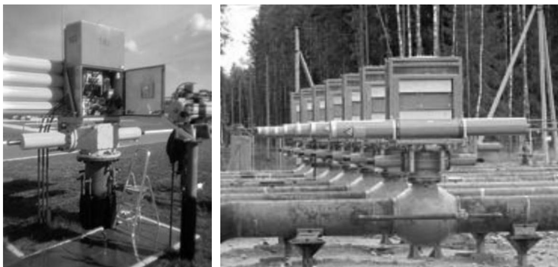
Рисунок 1.6 – Электрогидравлический привод фирмы ROTORK
