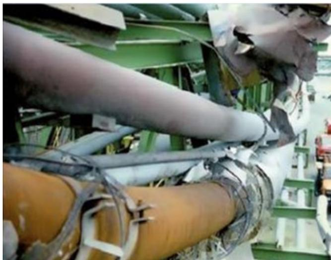
Рисунок 1.6 – Трубопроводы и крепления после гидравлического удара[24]
