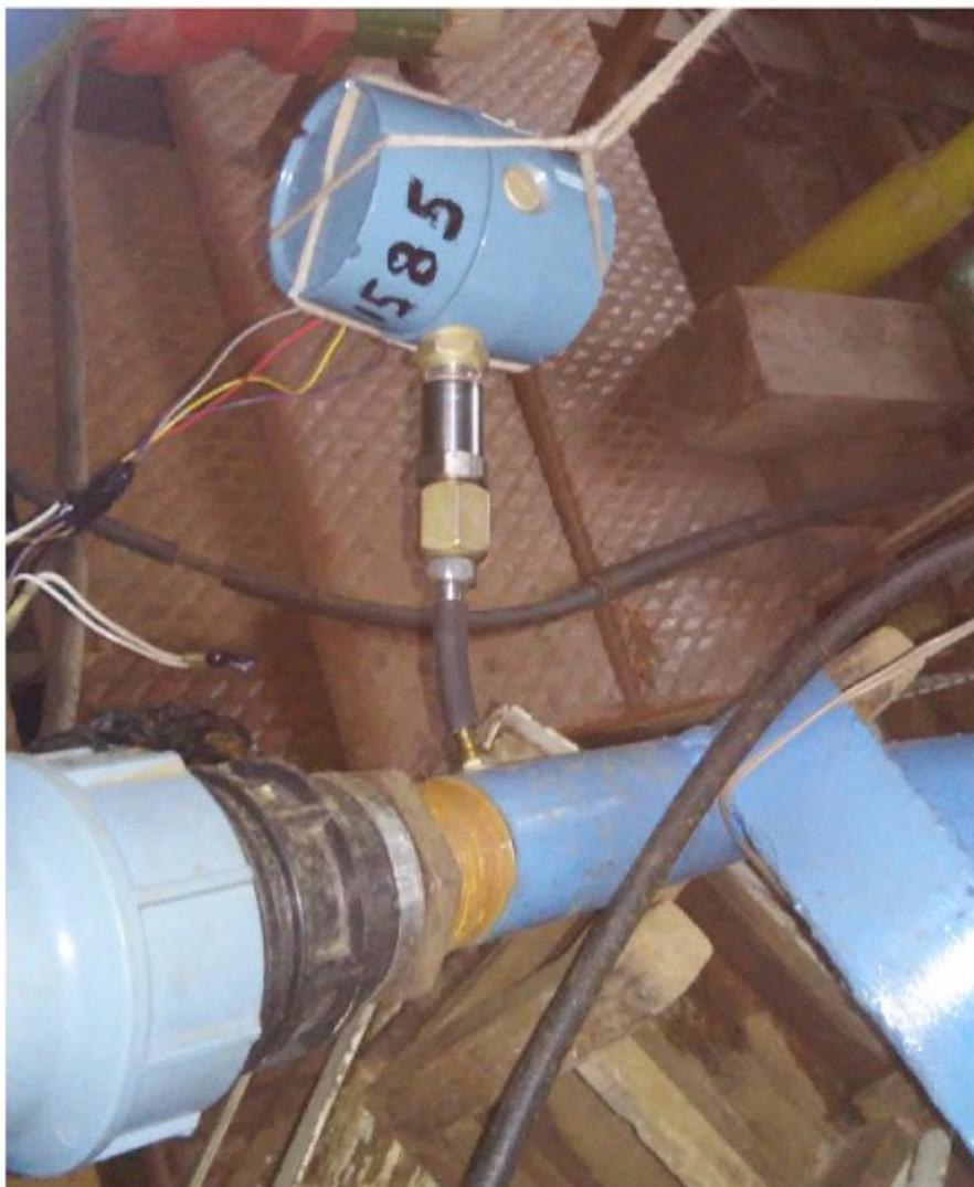
Рисунок 4.9 – Установка датчика давления типа «Сапфир 22-ДИ»
