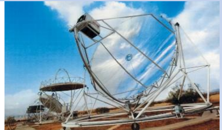
Сонячна установка тарілкового типу: а - схема сонячної установки тарілкового типу; б - сонячна установка потужністю 10 кВт на сонячній електростанції в Альмерії (Іспанія)
