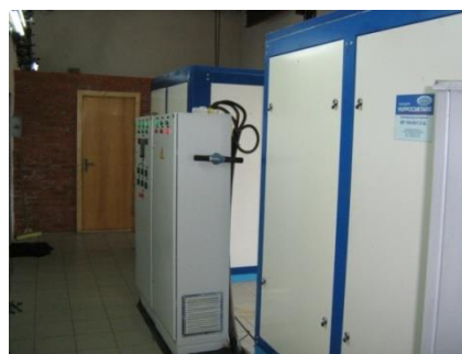
Рисунок 6.2 – Система керування локальних компресорних установок
