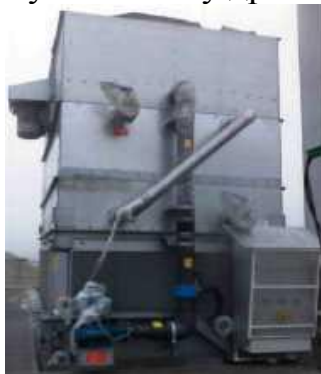
Рисунок 3.6 – Градирня з автоматичним насосним вузлом
