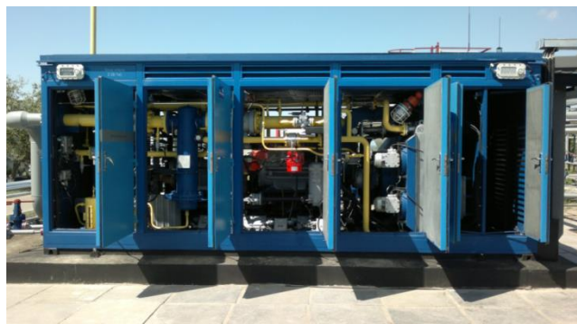
Рисунок 3.27 – Зовнішній вигляд газової гвинтової станції СГВв 315-20/0,5-25 У1
