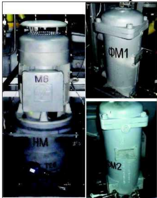
Рисунок 3.32 – Масляний насос, фільтри грубого і тонкого очищення масла
