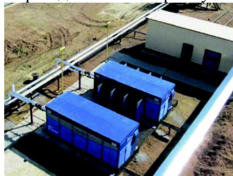
Рисунок 3.42 – Зовнішній вигляд газових гвинтових станцій СГВв 315-20/0,5-24 У 1
