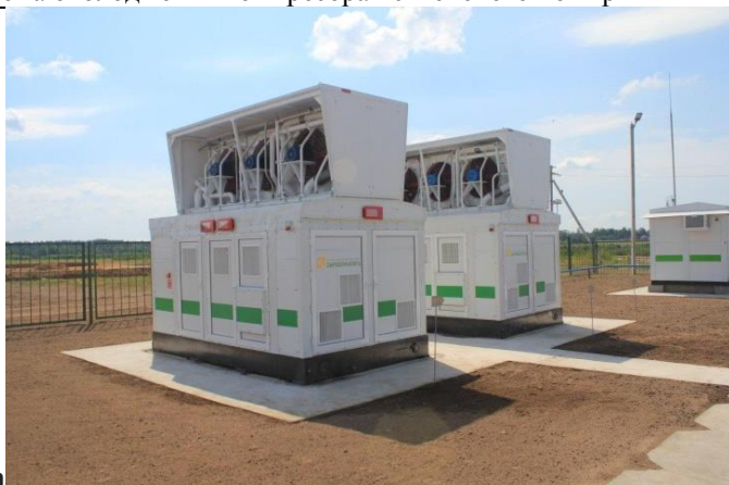
Рисунок 3.88 – Компресорна установка БКУ20/35 (а) і площадка на свердловині (б) під час реалізації технології термогазового впливу на Вишанському родовищі РУП «ВО «Білорусьнафта»
