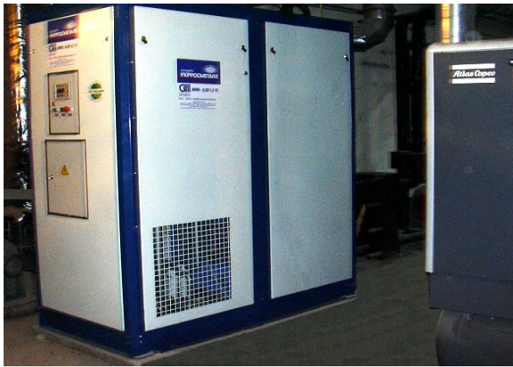
Рисунок 5.40 – Станція азотна переносна (фармацевтична галузь, Київська обл.)
