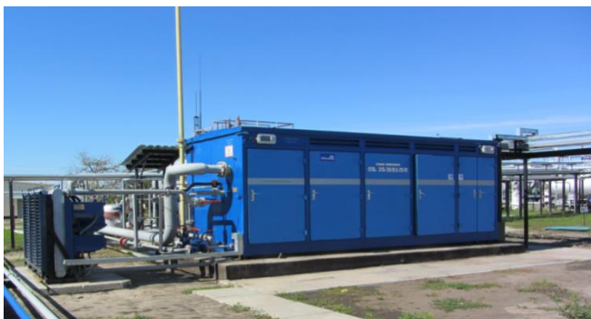
Рисунок 3.27 – Зовнішній вигляд газової гвинтової станції СГВв 315-20/0,5-25 У1
