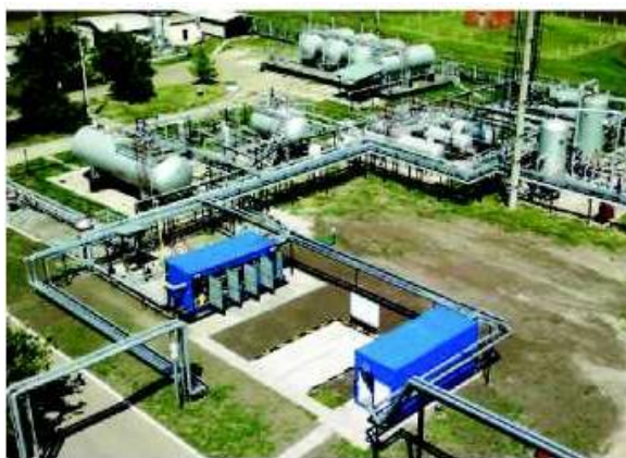
Рисунок 3.28 – Газова гвинтова станція СГВв 315-20/0,5-25 У1 на УКПНГ, Більськ
