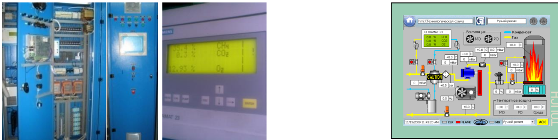
Рисунок 6.3 – Система керування установками компресорними газопідготувальними УКГ-5/8
