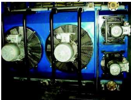
Рисунок 3.34 – Система охолодження масла і газу
