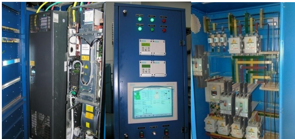
Рисунок 6.6 – Система керування компресорними установками для стиснення коксового газу та інших вибухонебезпечних середовищ
