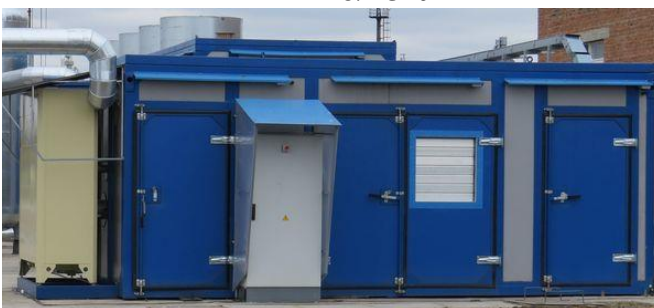
Рисунок 3.16 – Модуль компресора низького тиску станції ААВН-40/25 У1
