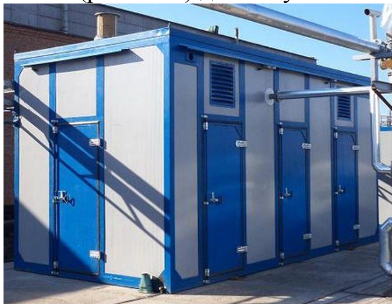
Рисунок 3.18 – Модуль поділу повітря станції ААВН-40/25 У1
