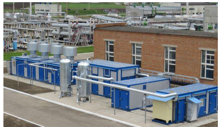
Рисунок 3.15 – Робота станції ААВН-40/25 У1 на Котелевському ГКР
