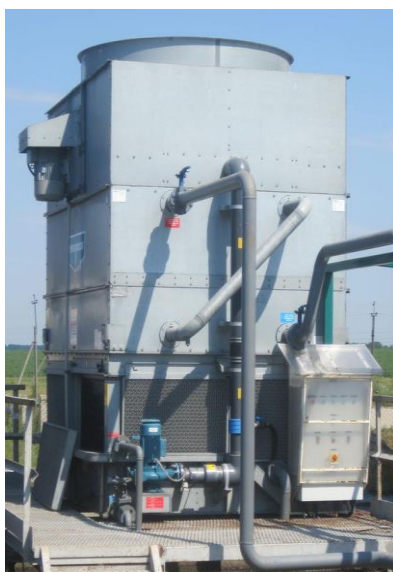
Рисунок 3.21 – Охолоджувач теплоносія станції
