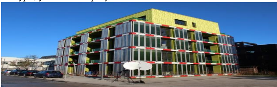
Рис.1 Будівля з біо-адаптивним фасадом з мікроводоростей.
