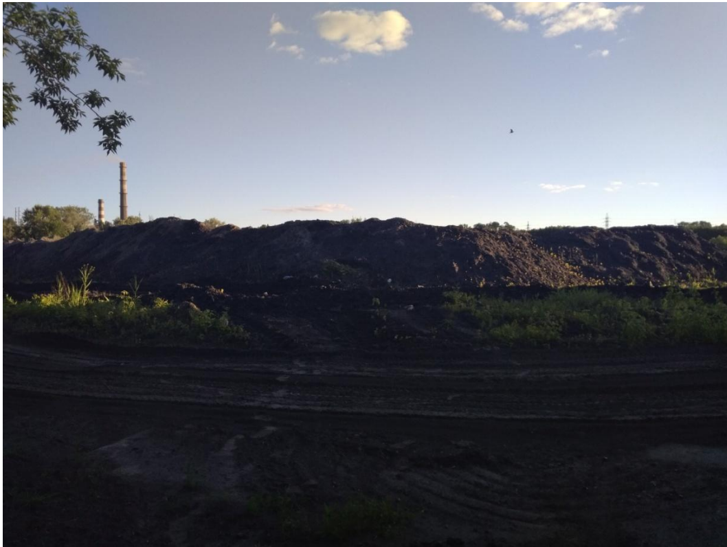
Рисунок 2.3 – Загальний вигляд золошлаконакопичувача
