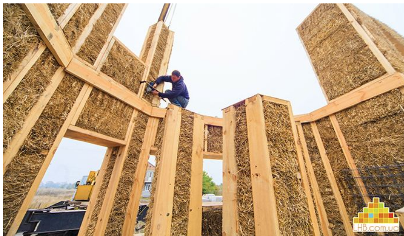
Рисунок 9.29 – «Солом'яний будинок» в процесі будівництва (Аббасова, 2017)
