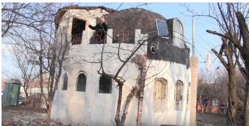
Рисунок 9.21 – Купольний будинок-термос у Полтаві (Дома, 2017)
