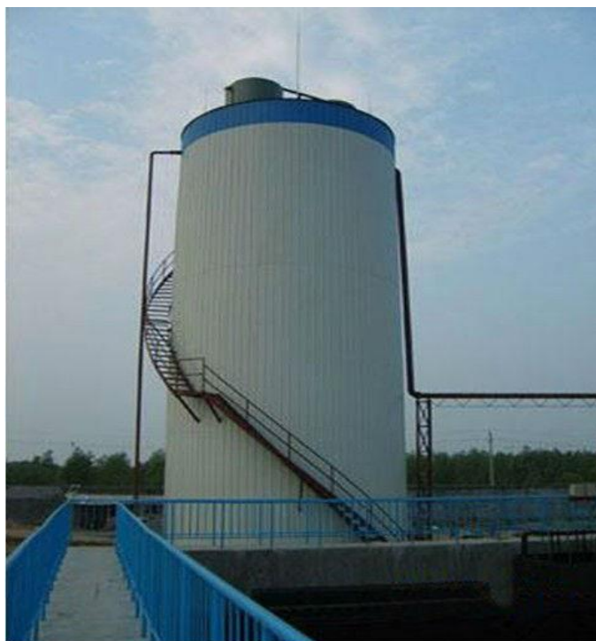
Рисунок 5.17 – UASB-реактор, Shandong Jinhaosanyang Environmental Protection Equipment Co., Ltd. (Китай)
