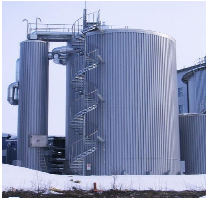
Рисунок 5.15 – EGSB-реактор, пивоварна компанія «Ланін Культа» (Фінляндія)
