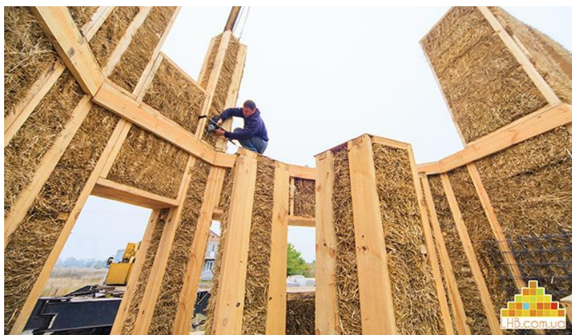
Рисунок 9.28 – «Соломенный дом» в процессе строительства (Аббасова, 2017)
