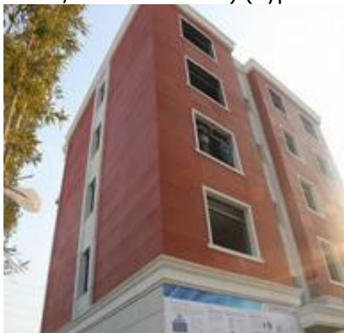
Рисунок 4.2 – Дом, распечатанный компанией WinSun на 3D-принтере (Шанхайская, 2015)
