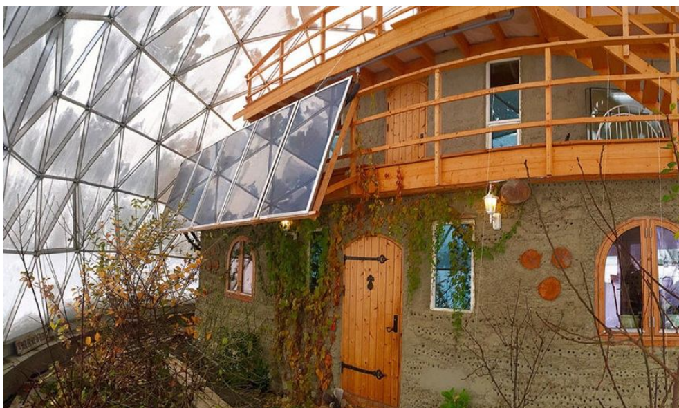
Рисунок 9.18 – Житлові приміщення будинку під скляним куполом (Как построить, 2017)
