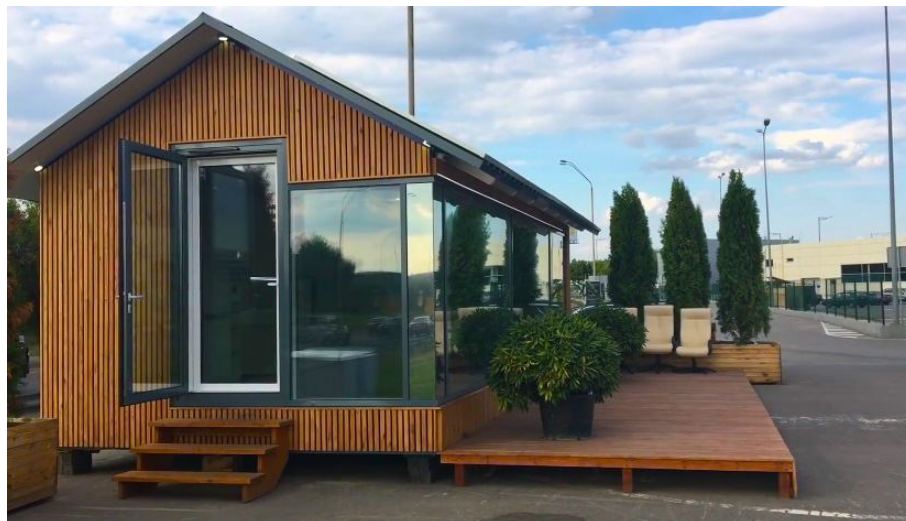
Рисунок 9.24 – PassiveDom: «розумний» екобудинок, роздрукований на 3D-принтері (PassiveDom, 2017)
