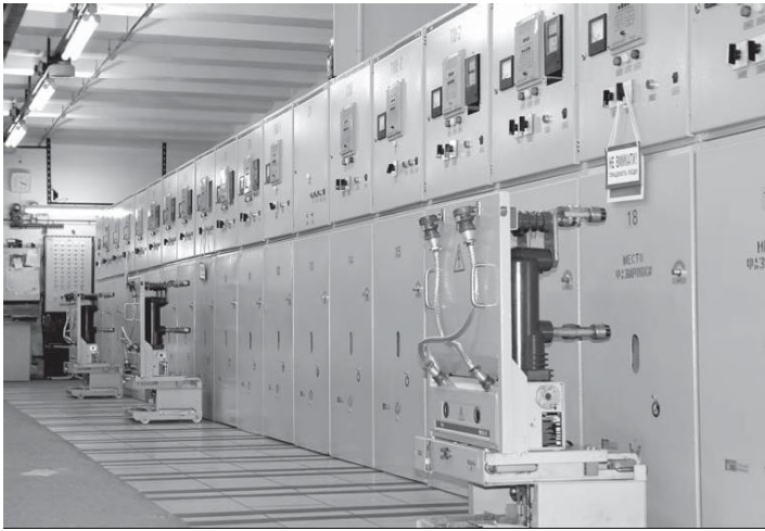
Рисунок 4.22 – Розподільний пункт 10 кВ виробництва ВАТ «Рівненський завод високовольтної апаратури»
