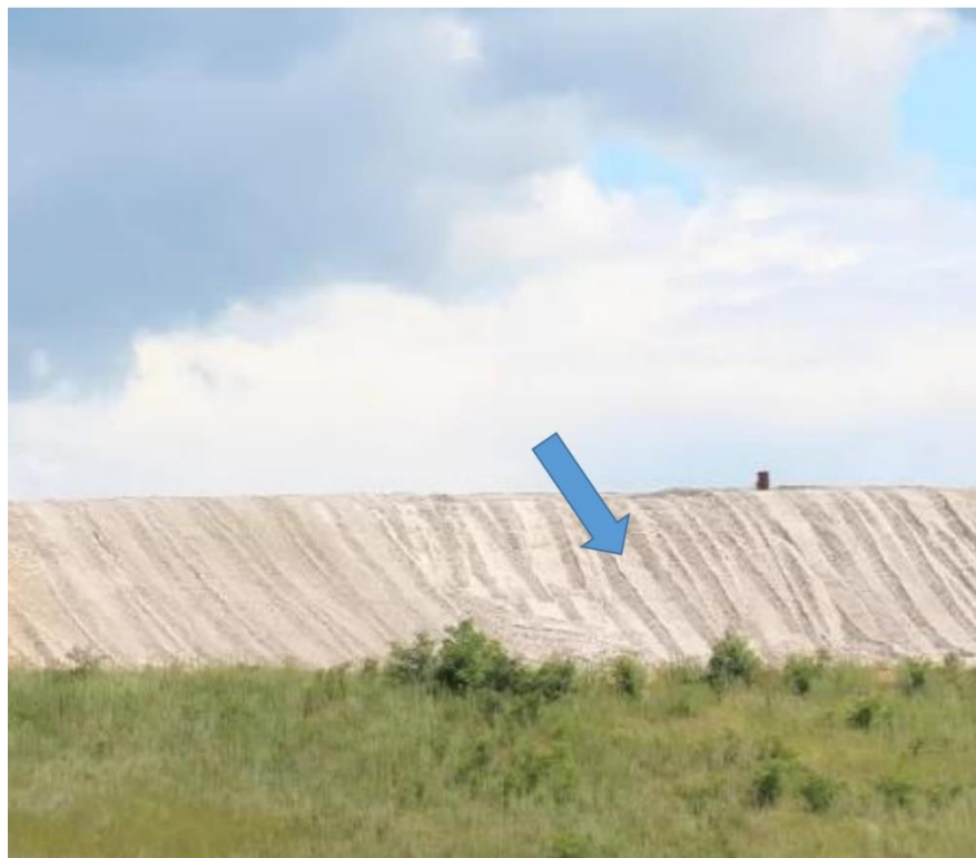
Рисунок Б.1.3 – Нерекультивована частина діючого відвалу фосфогіпсу після інтенсивних атмосферних опадів: стрілкою наведено напрямок руху поверхневого стоку
