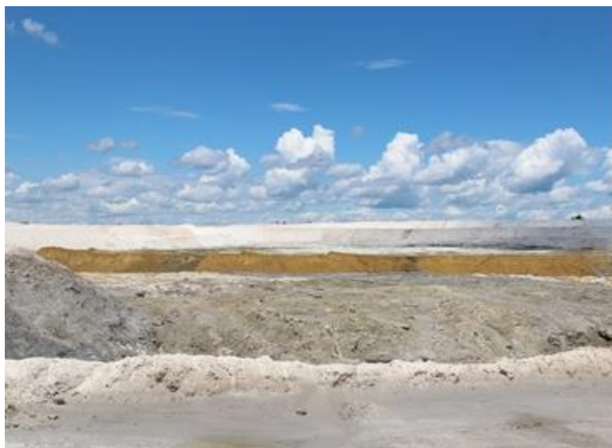
Рисунок Б.1.2 – Верхня площадка масиву відвала із свіжим фосфогіпсом та насипом із піску та суглинку для перекриття платформи
