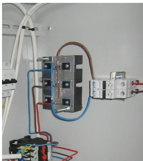
Рисунок 2.16 – Блок випрямлячів
