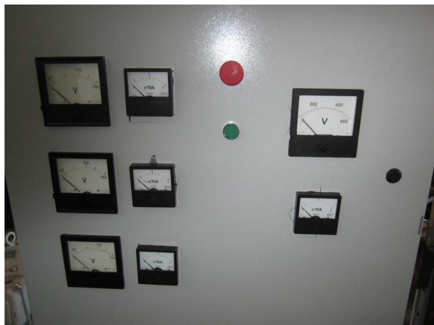
Рисунок 2.18 – Амперметри та вольтметри змінного (зліва) та постійного (зправа) струму.
