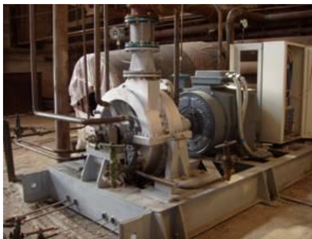
Рисунок 1.3 - Турбогенераторна установка на основі ступеня тиску з повторним підведенням робочого тіла, тобто за багатоступінчасто-петлевою схемою розширення на одному робочому колесі.
