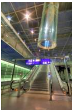
Рис. 4.5. Световой колодец на станции метро в Берлине. Нижняя часть колодца
