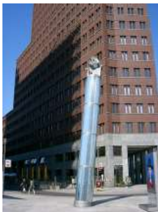
Рис. 4.4. Световой колодец на станции метро в Берлине. Верхняя часть
