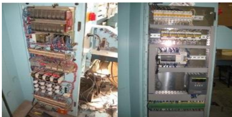
Рисунок 1.1 - Перекомутація електричної шафи гільйотини
