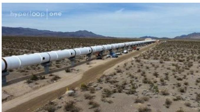
Рисунок 7.2 – Испытательный участок гиперлупа (Илон, 2017).
