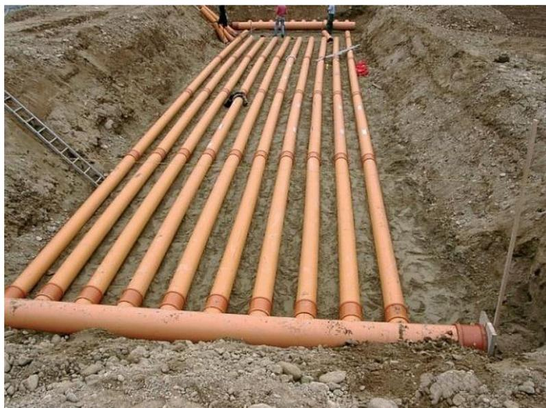
*Рисунок 5.1 – Трубы для сбора подземного тепла/прохлады (Закопана, 2015).*
