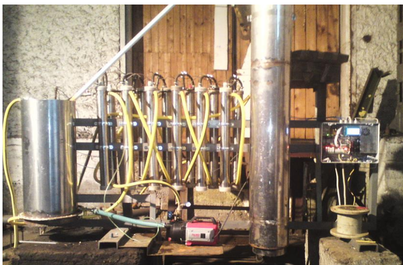
Рисунок 3.20 – Зовнішній вигляд технологічних елементів ВМЕВ (загальний вигляд установки)
