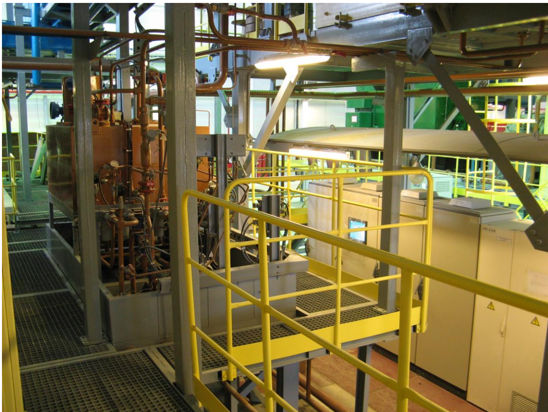
Рисунок 2.5 - Шафи автоматики ЕБ
