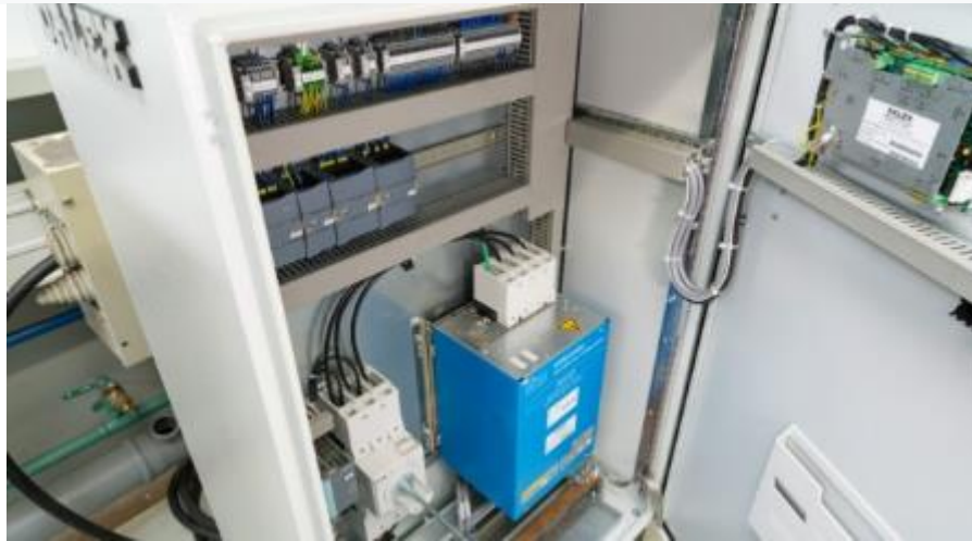
Рис. 3.8. Монтаж ПЛК SIMATIC S7-1200 в автоматичній системі зварювання [26]
