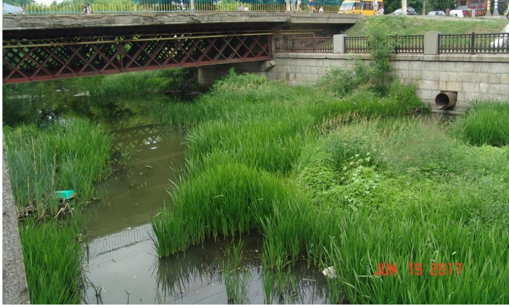
Рисунок 3.6 – Порушення стану русла і берега р. Сумка: укріплений берег на спрямленій ділянці русла в центрі м. Суми.
