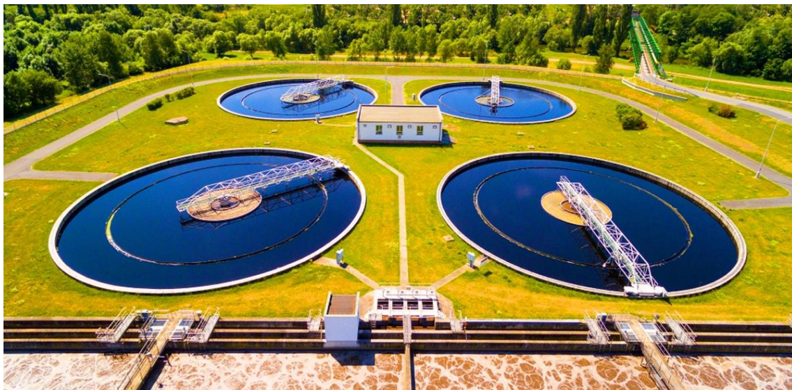
Рисунок 2.5 – Окситенки, зона аерації (центральна частина) і муловіддільник (по периферії)
