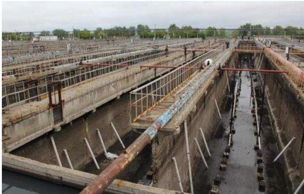
Рисунок 2.3 – Поздовжній аеротенк
