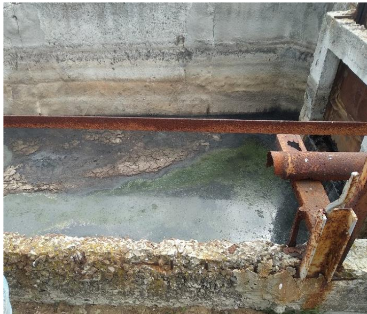
Рисунок 1.7 — Лоток Вентурі (вимірювальний)
