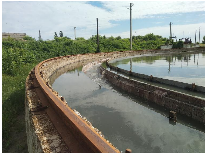
Рисунок 1.8 — Первинні радіальні відстійники першої черги
