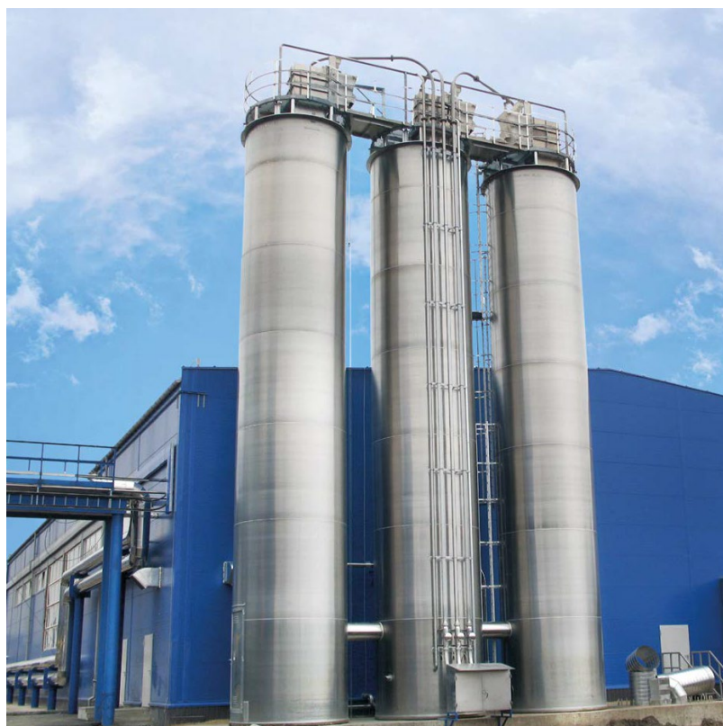
Рисунок 3.4 – Обладнання для очищення повітря
