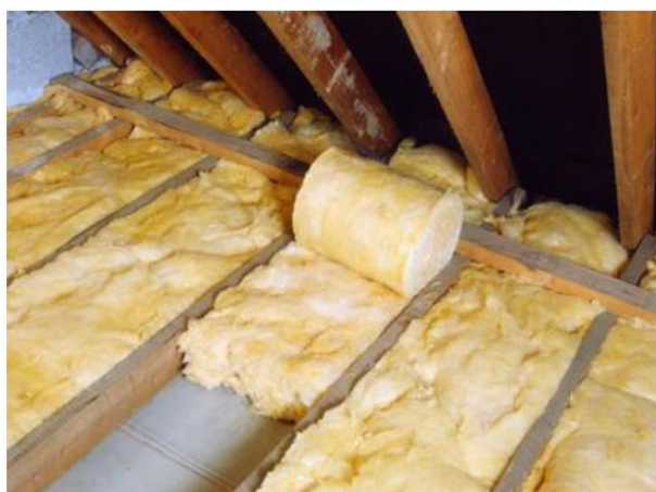
Рисунок 11 - Теплоізоляція горища: 1) Парозахисної шар; 2) Супердифузійна мембрана ; 3) Мінеральна вата; 4)Парозахисна плівка;
