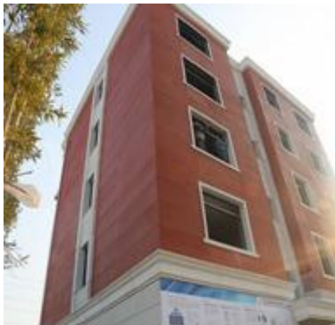
Рисунок 3.2 – Будинки, надруковані на 3D-принтері Шанхайською компанією WinSun (Шанхайская, 2015)
