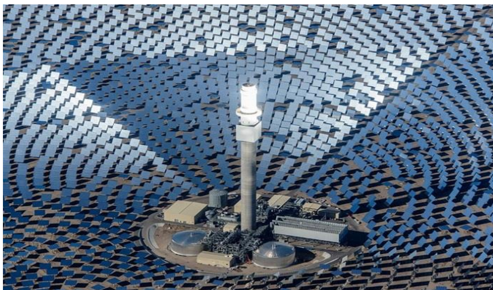
Рисунок 8.5 Електростанція Crescent Dunes Solar Reserve, Невада, США. Джерело: онлайн-видання Power Electronics, 6 Promising Energy Storage Options to Tie into the Grid, Feb'18.
