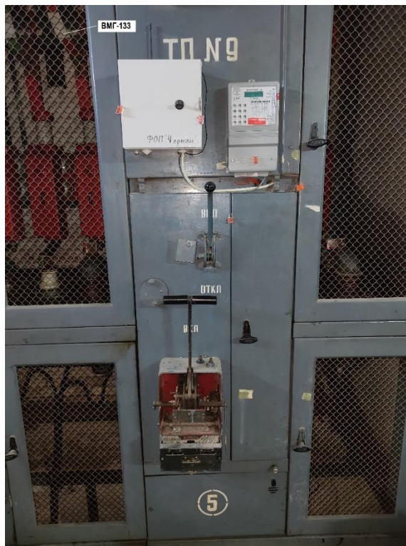
Рисунок 1.5.7 – Вигляд масляного вимикача ВМГ-133 у субспоживача № 6 ФОП Чернишиш Г.П.
