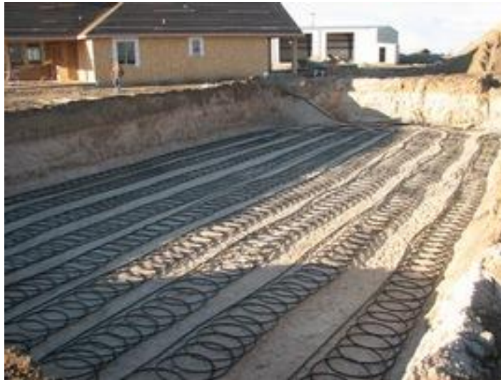
Рисунок 1.2 – Приклад прокладання труб [5]
