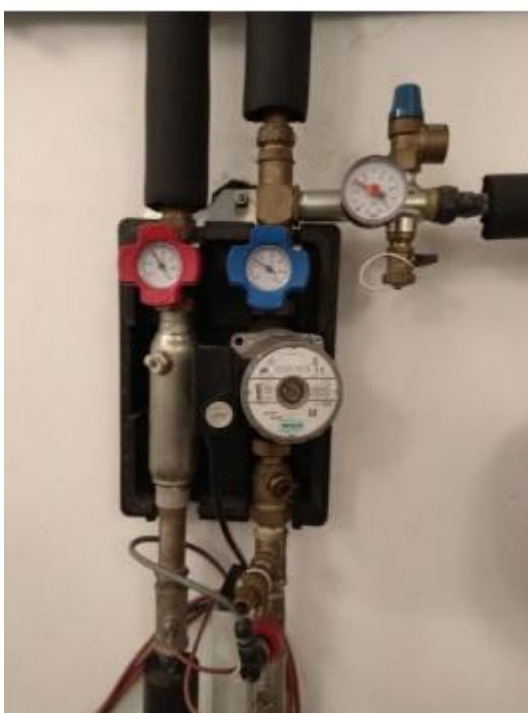
Рис. 4.47 - Циркуляційний насос від Wilo
