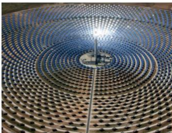
Рис. 2.20 - Геліостати навколо сонячної вежі [ths.rwth-aachen.de]
