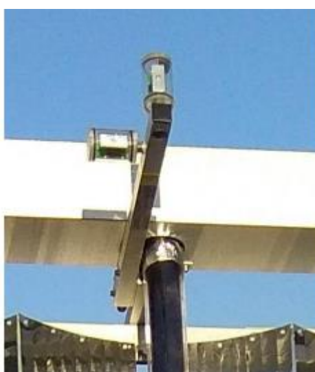
Рис. 4.40 - Встановлення колекторних датчиків ELFRAN
