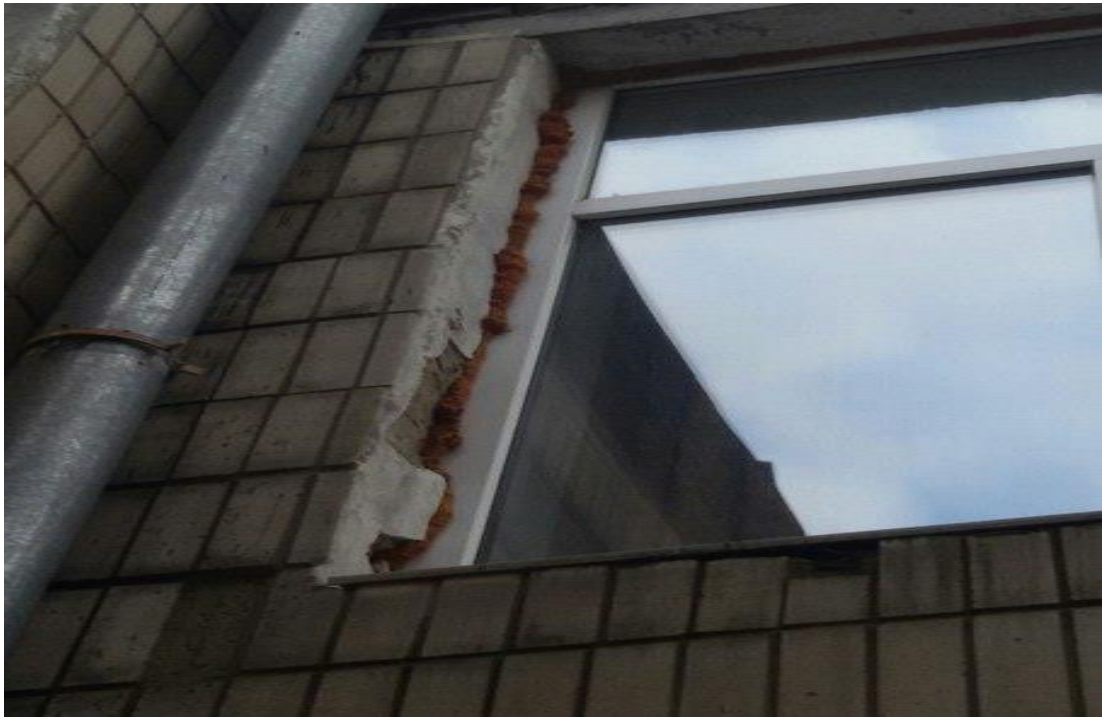
Рисунок 1.3 – Неякісні зовнішні відкоси
