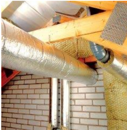
Рисунок 4.2 – Ізоляція трубопроводів систем опалення [26]
