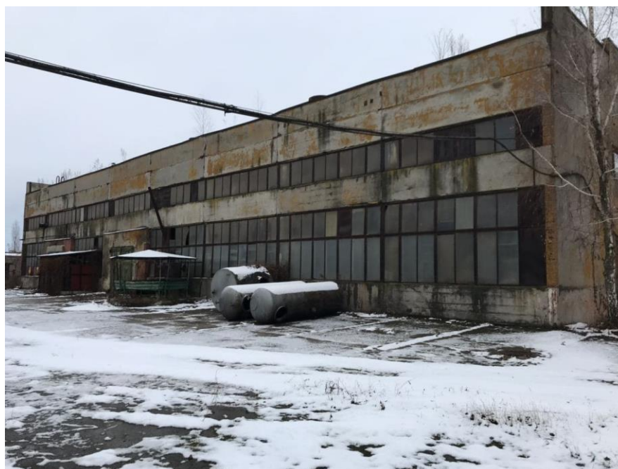
Рисунок 1.3 – Будівля ремонтно-механічного цеху
