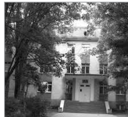
Рисунок 4.24 – Закарпатська обласна станція переливання крові (фото з відкритих джерел)
