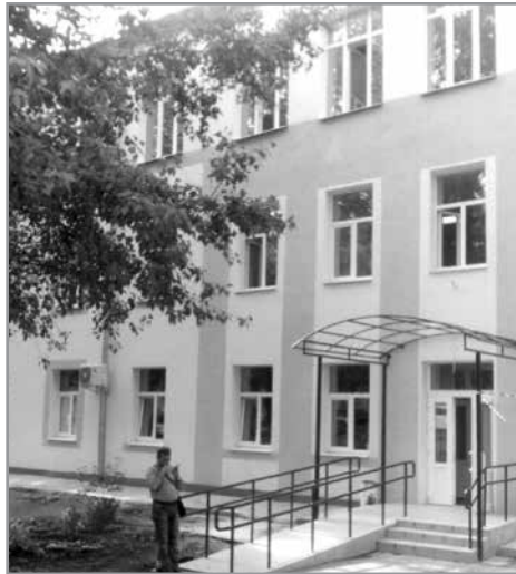
Рисунок 4.34 – Кропивницька обласна станція переливання крові до ремонту (архівне фото)
