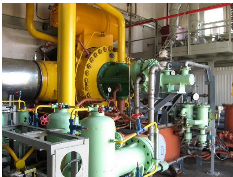
Рисунок 1.2 - Нагнітач ГПА
