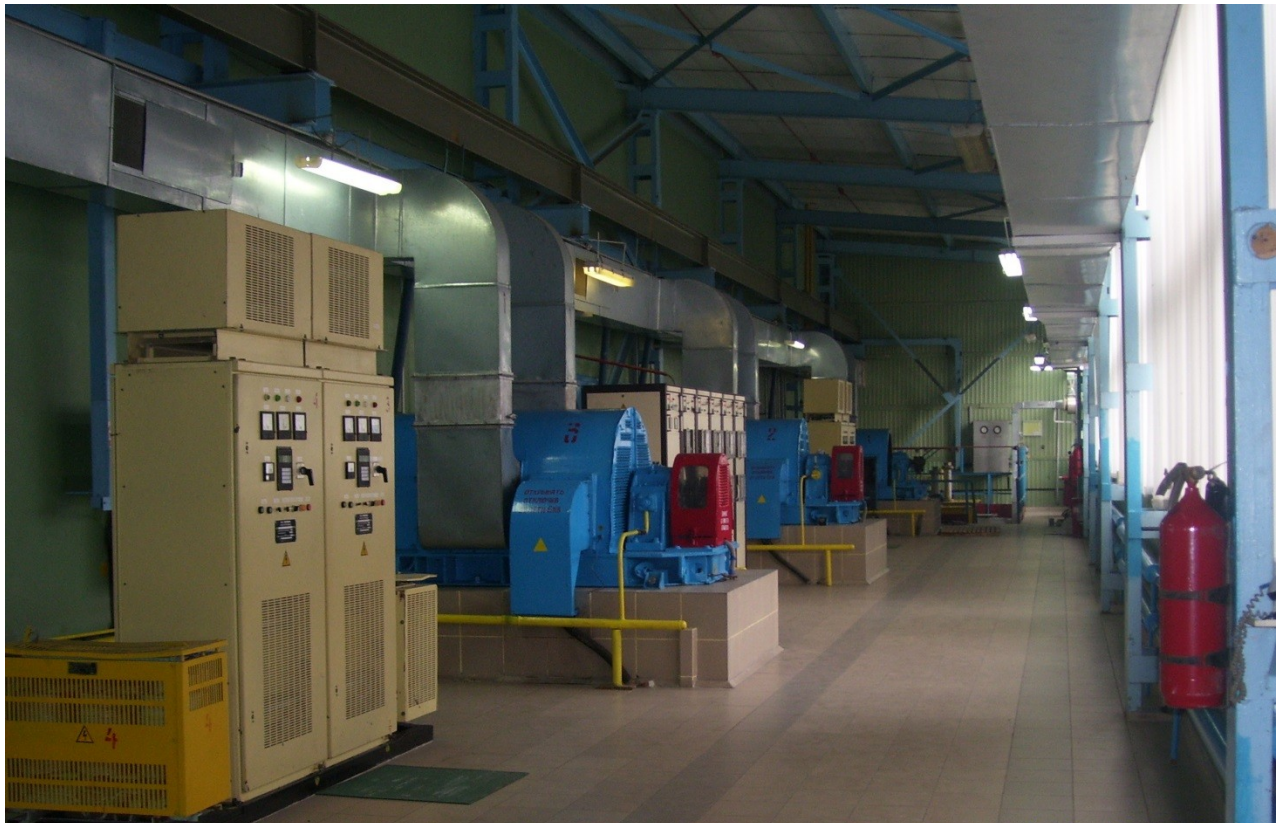
Рисунок 1.2 - Електропривід МН СТД 2000
