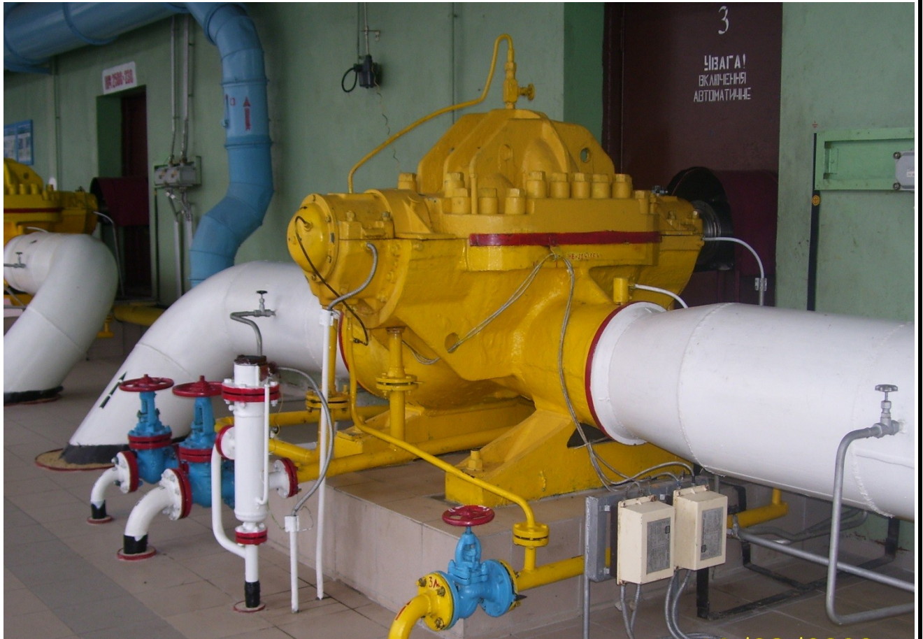
Рисунок 1.1 - Магістральний насос МН2500-230
