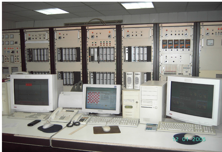
Рисунок 2.2 - Автоматизоване робоче місце оператора НПС
