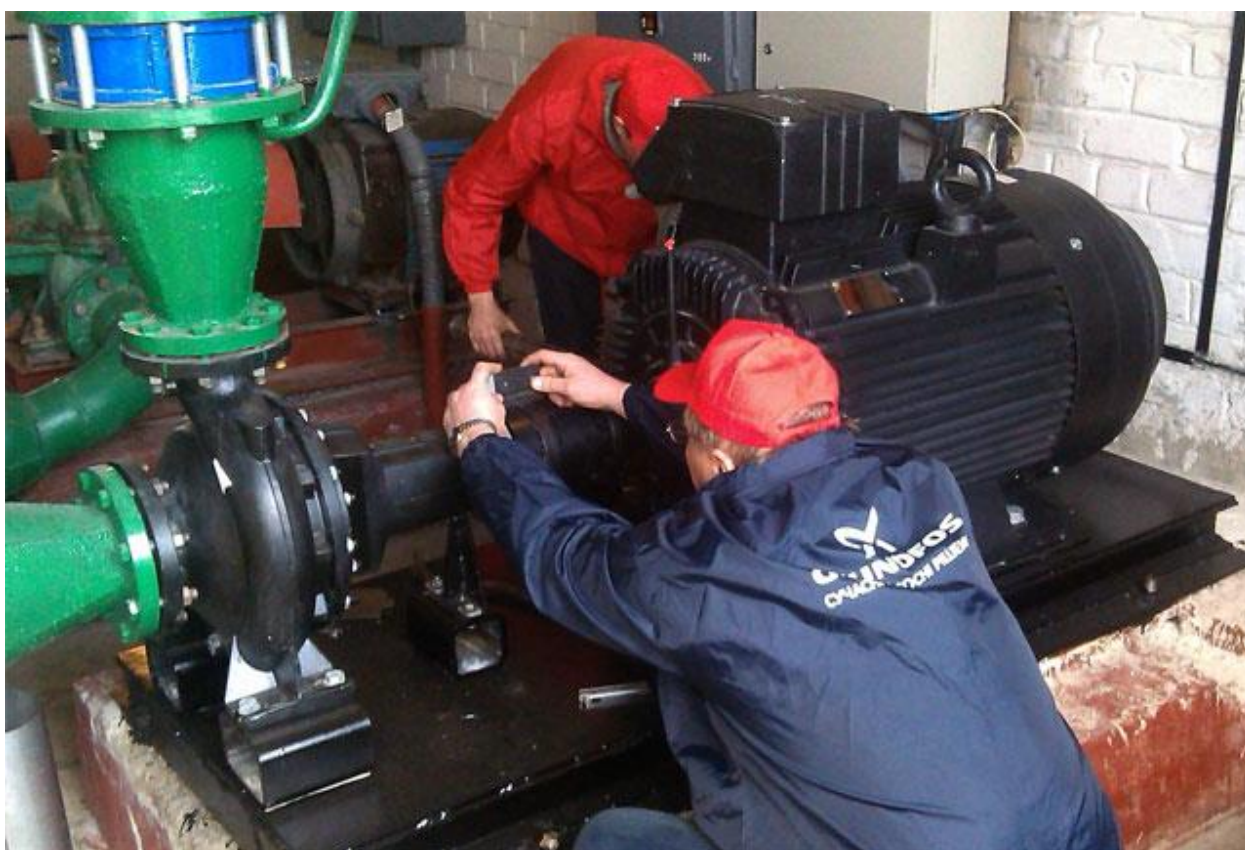
Рисунок 6 - Установка насоса
