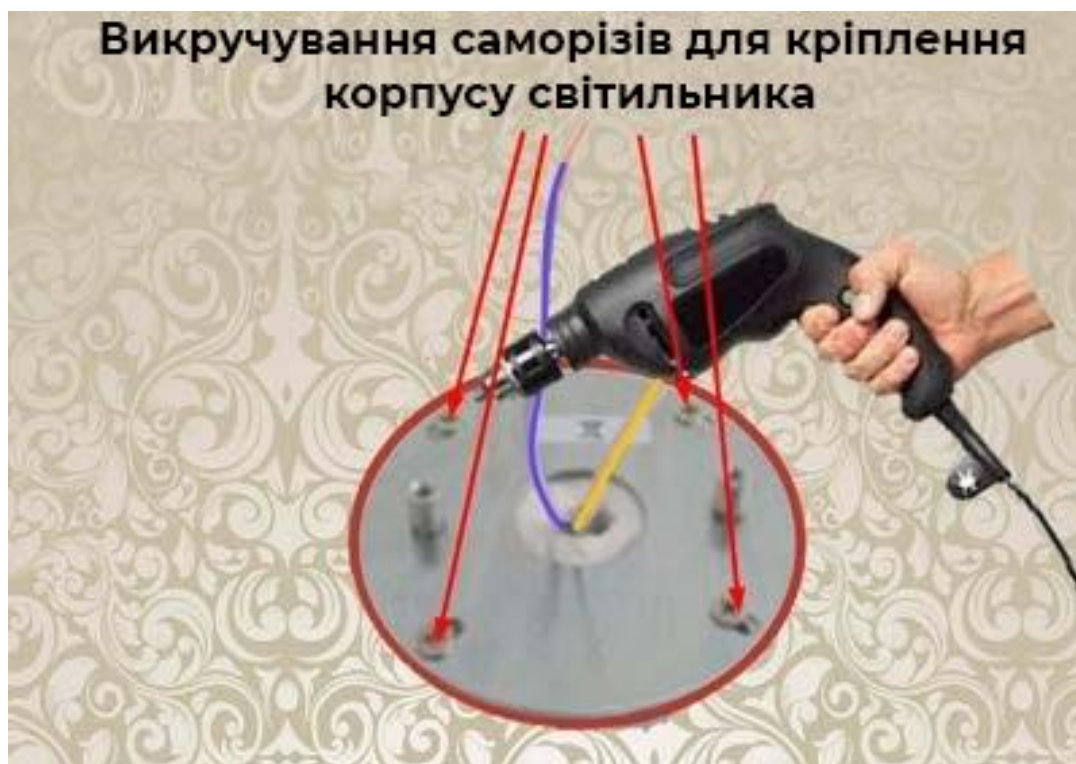
Рисунок 3.11 - Монтаж корпусу світильника
