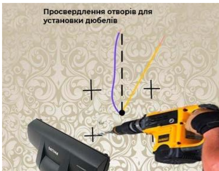
Рисунок 3.7 - Ударний перфоратор
