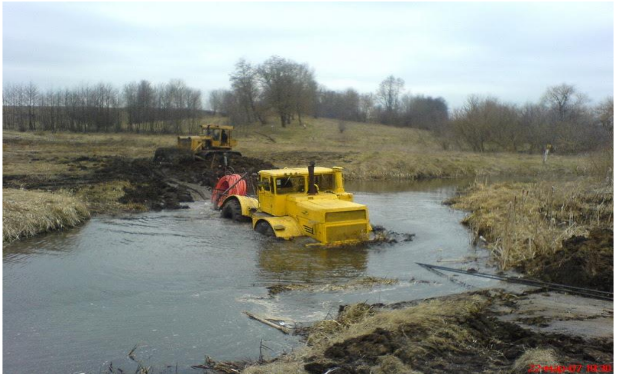
Рисунок 13 – Прокладка оптичного кабелю через водні перешкоди
