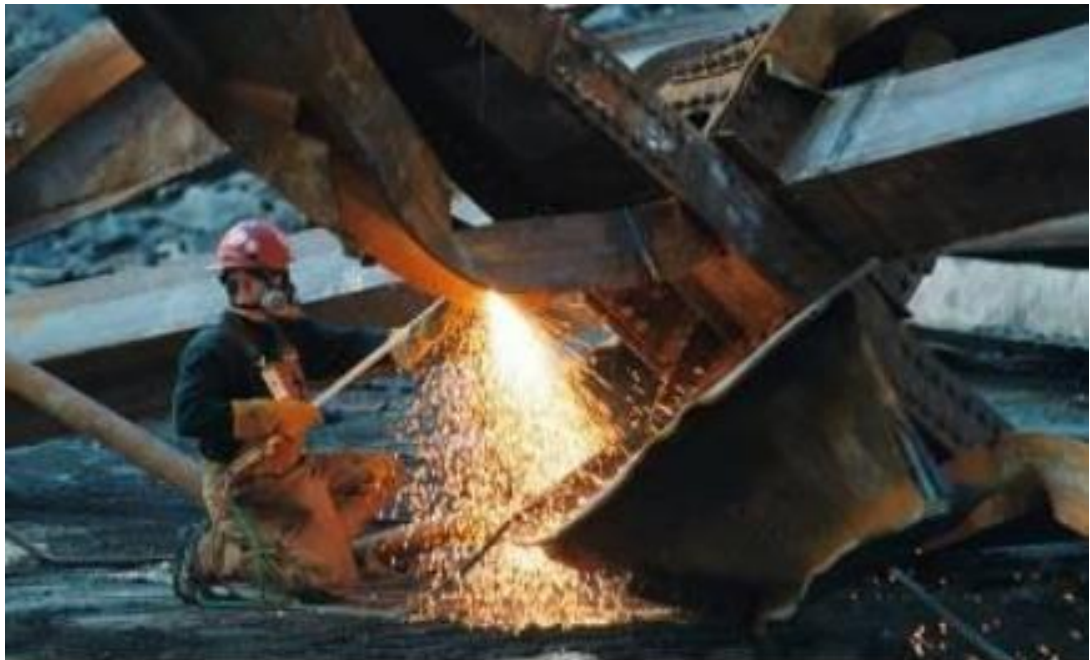
Рисунок 2.7 – Різання металу киснево-газовим пальником
