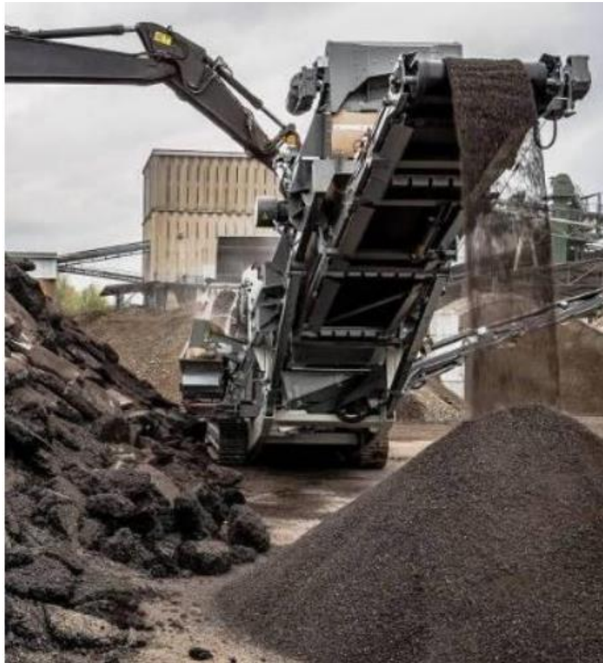
Рисунок 2.4 – Подрібнення асфальтобетонного брухту на асфальтобетонному заводі
