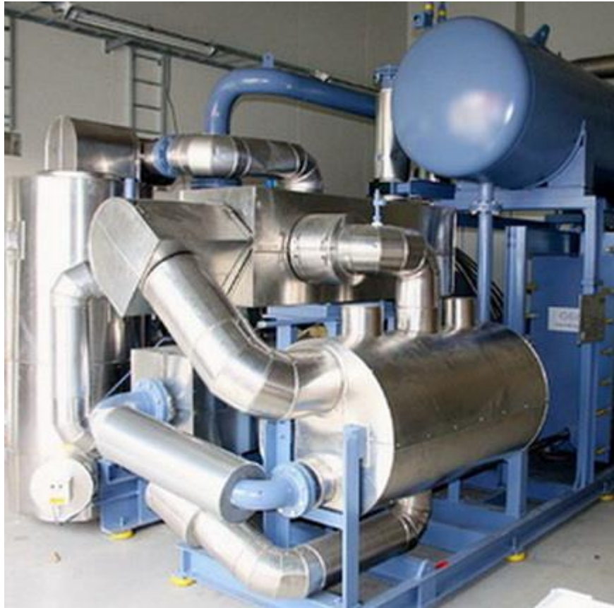
Рисунок 1.5 – Тепловий насос, що працює на аміаку
