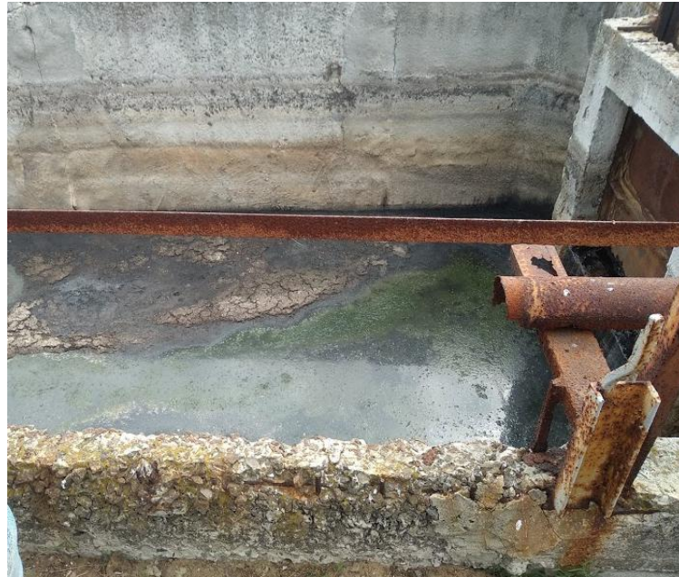
Рисунок 1.7 — Лоток Вентурі (вимірювальний)
