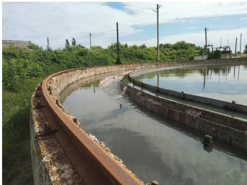
Рисунок 1.8 — Первинні радіальні відстійники першої черги
