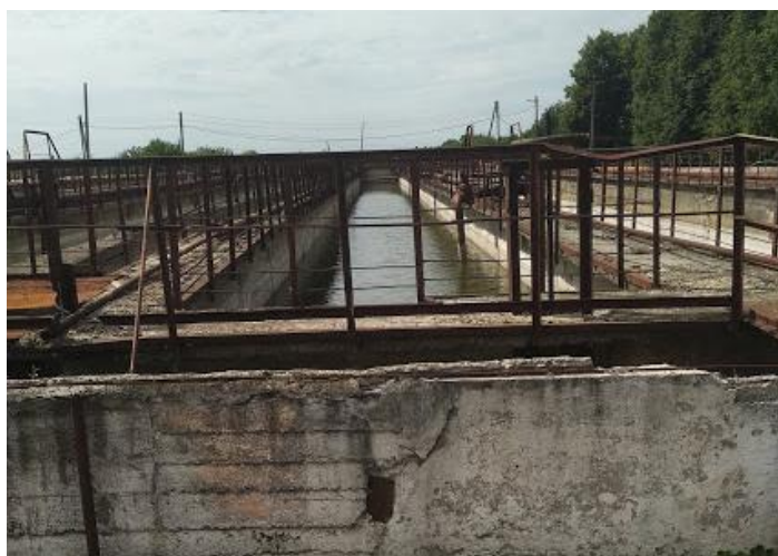
Рисунок 1.6 — Горизонтальний пісковловлювач
