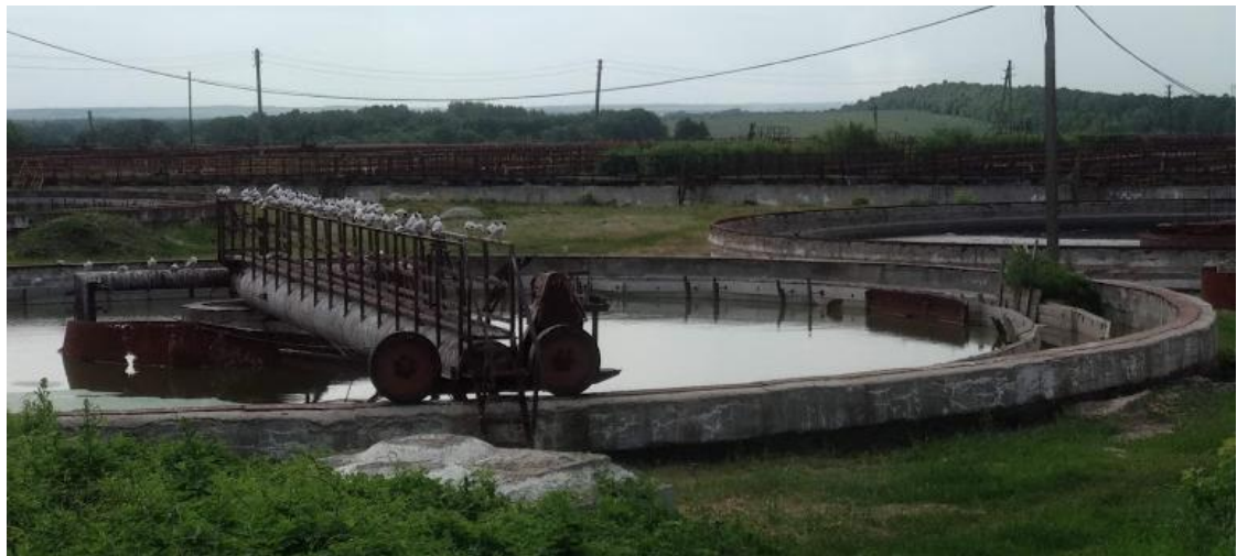
Рисунок 1.10 — Вторинні відстійники
