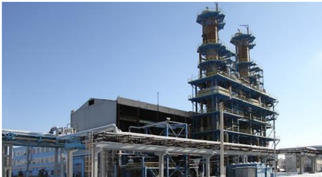
Рисунок 4.1 – Змішаний варіант компонування цеху виробництва слабкої азотної кислоти
