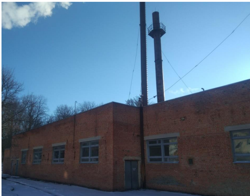
Рисунок 1.1 – Загальний вигляд котельні по вул.Санаторна, 3
