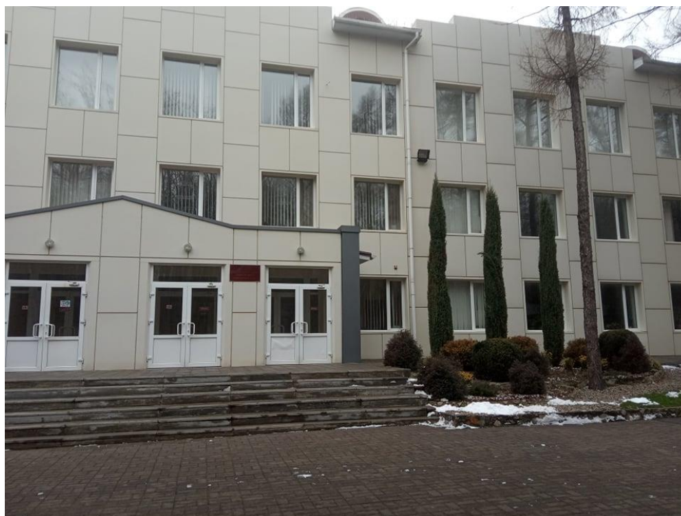
Рисунок 1.1 – Загальний вигляд фасаду будинку
