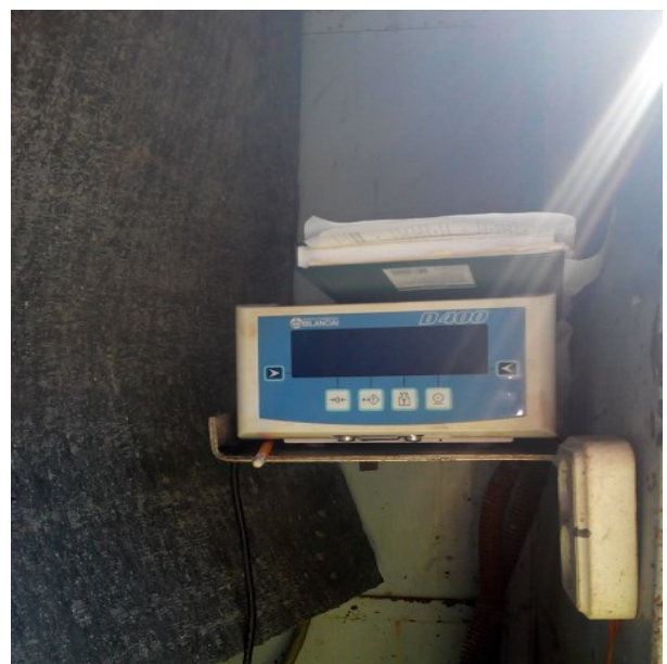
Рисунок 8г – ТПУ. Загальний вид
