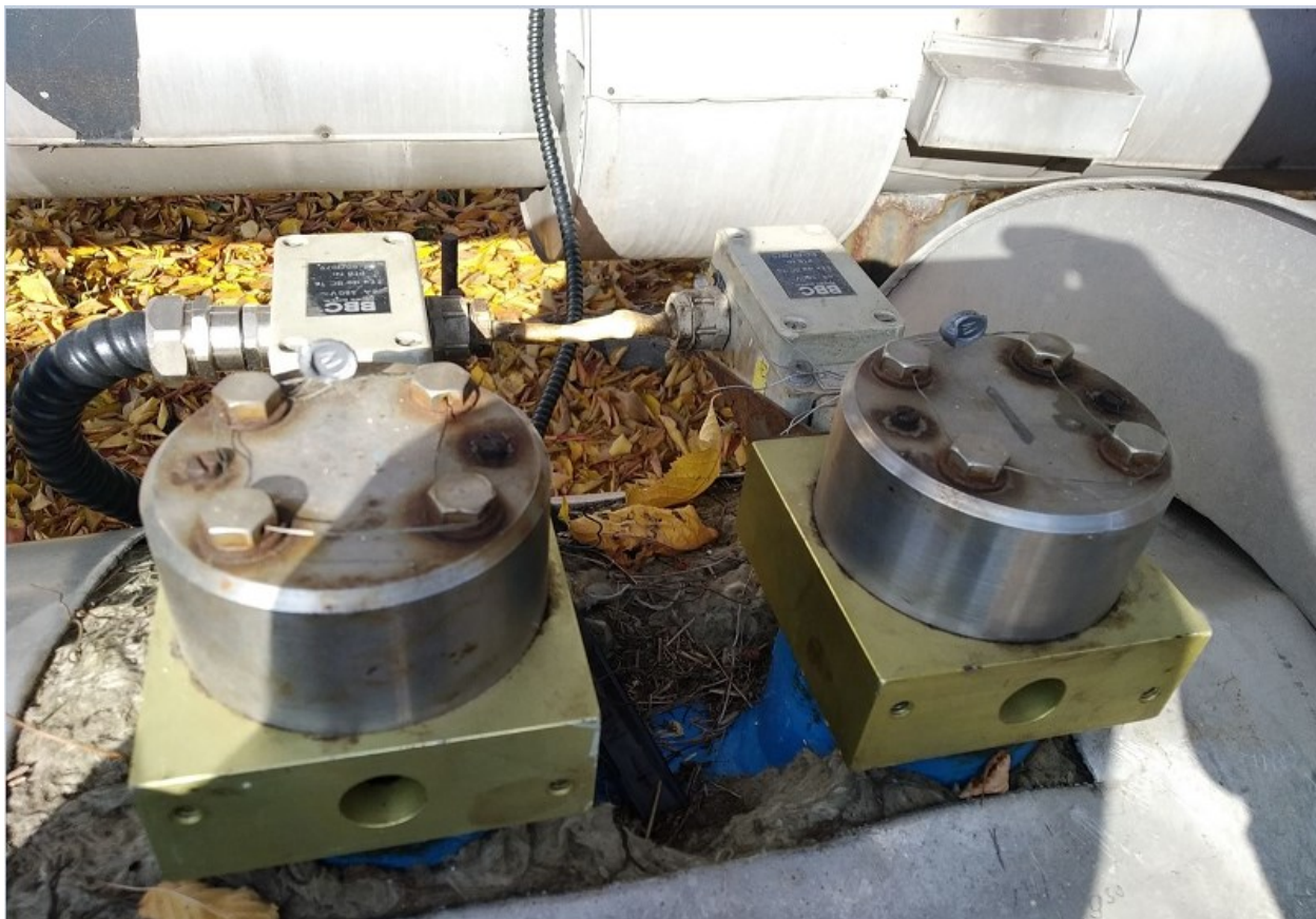
Рисунок 7в – Загальний вид (Детектори проходу кулі)
