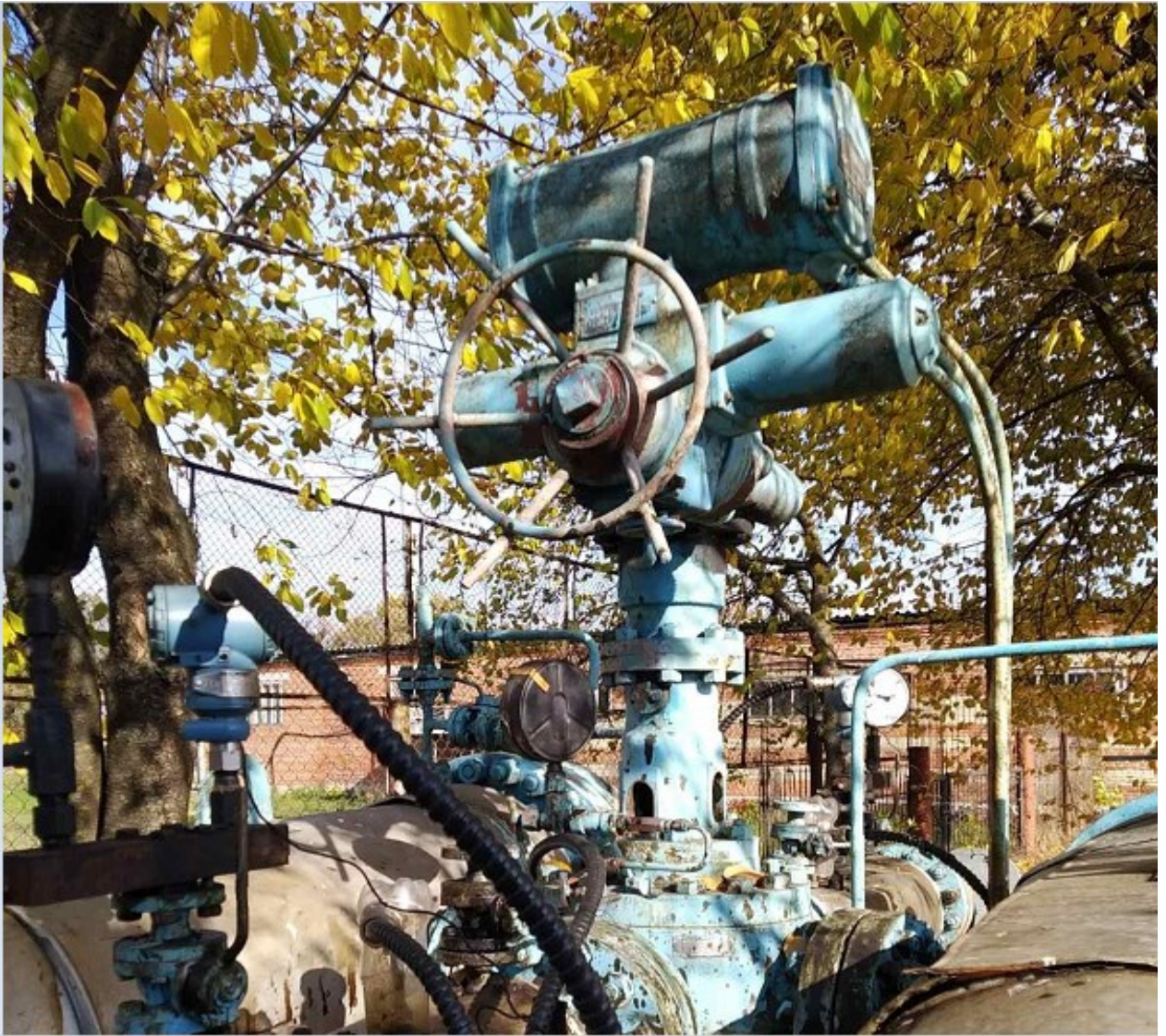
Рисунок 7в – Загальний вид (Чотирьохходовий кран)
