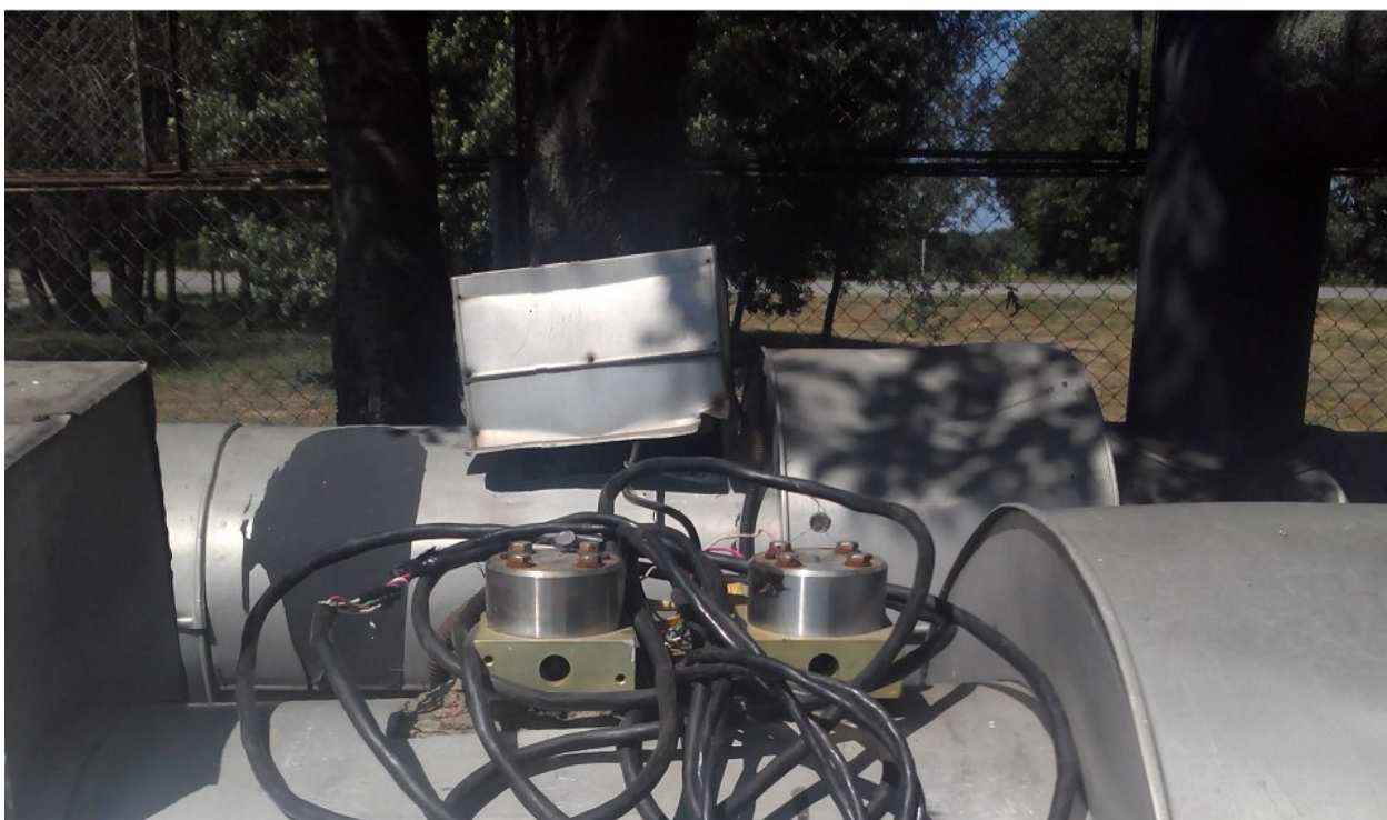
Рисунок 7г – Загальний вид (Детектори проходу кулі)
