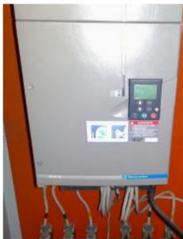
Рис. 2.4.6 Частотний перетворювач Altivar 38
