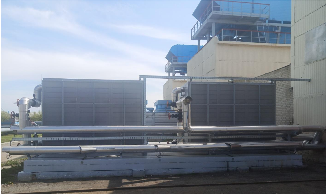
Рисунок 1.2 - Приєднувальні виводи трубопроводів апарату АПОО
