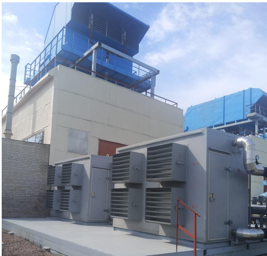
Рисунок 1.1 - Апарат повітряного охолодження оливи
