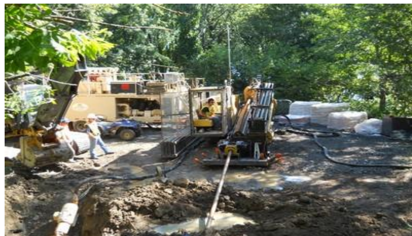
Рисунок 5 – Робота установок методом ГНБ
